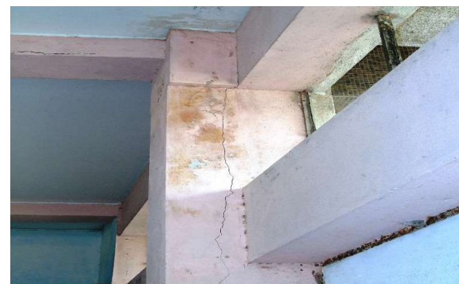
Patologia Viga Forte-Pilar Fraco, Eventual Resultado de Sismo
